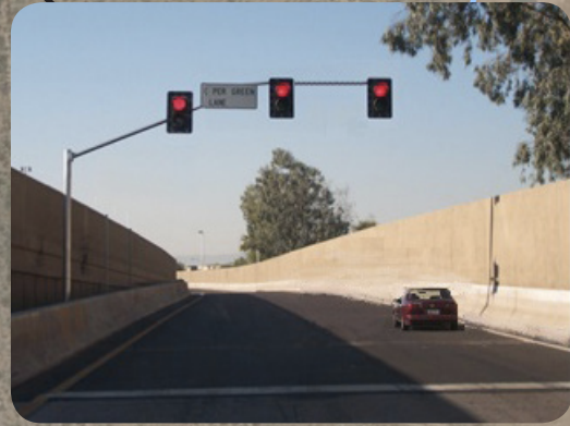
Ramp Meter Example
